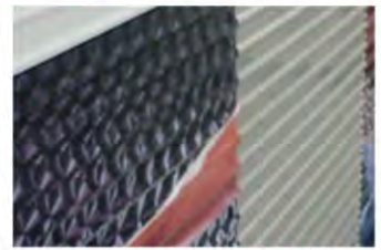
コルゲートへの施工例
