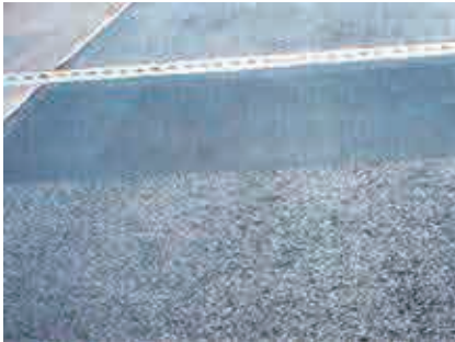
ジョイント部の段差修正
